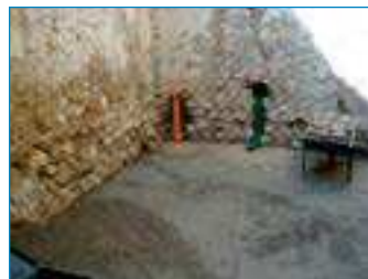
2 Gettata preparatoria di cemento 2 Concrete pouring
