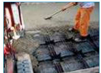
8 Posizionamento rete metallica + massetto 8 Final installation of electro welded net + concrete pouring
