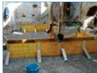
3 Preparazione del cordolo 3 Ring beam construction
