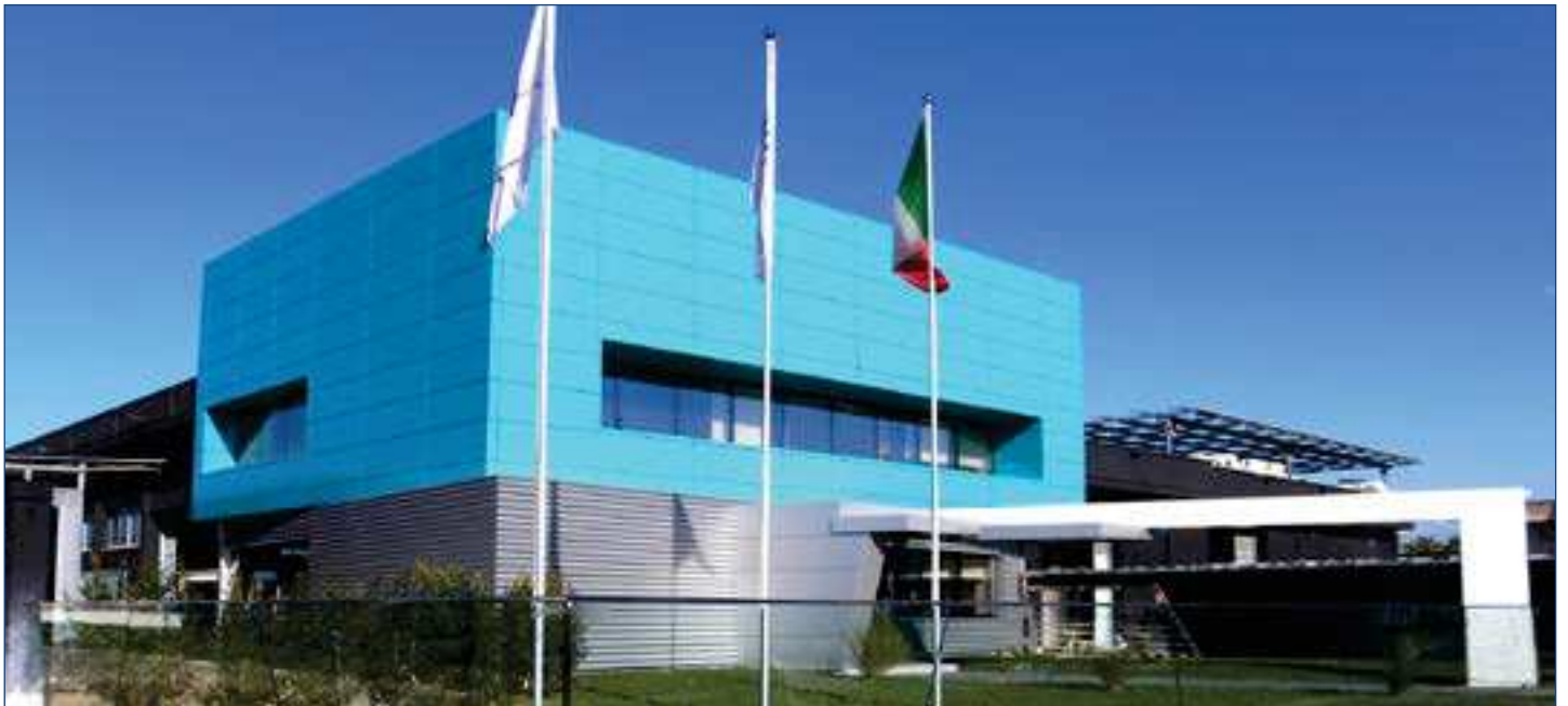
AIRGAMA - uffici e stabilimento / AIRGAMA - offices and factory
